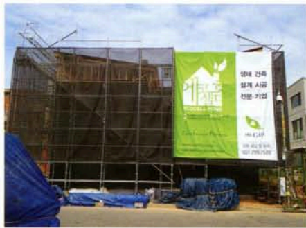
▲ 에코셀홈 시공현장에는 시스템 비계와 분진막을 설치해 작업능률을 높이고 이웃간 분쟁을 막는다.
