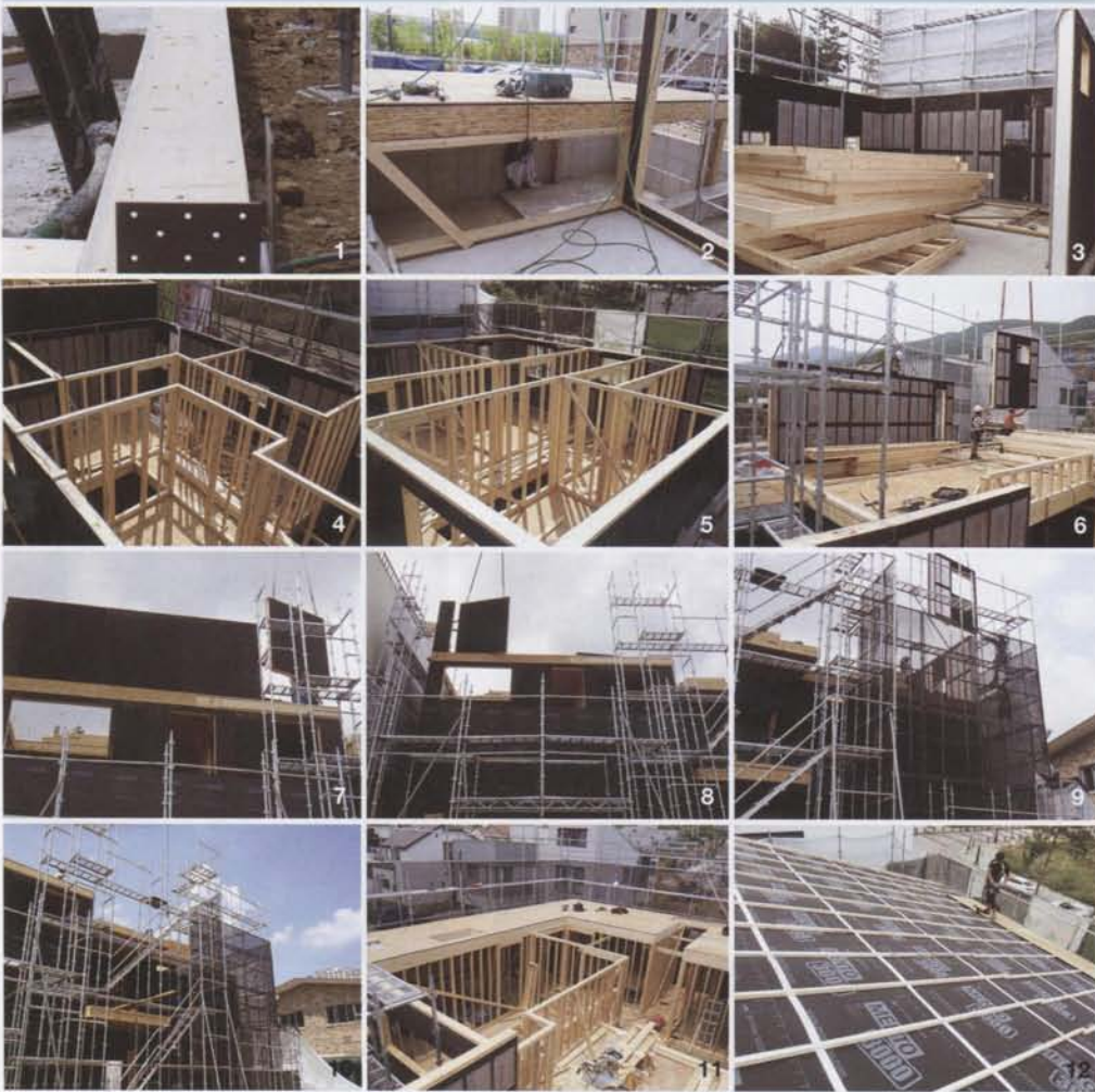
1 에코셀 기초 결합부 시공. 2 슬래브 시공. 3 4 5 6 7 8 9 10 11 에코셀 조립. 12 지붕 마감. • 기초 공사 완료 후 에코셀을 조립하는 과정은 채 3시간이 걸리지 않는다. 현장을 정리하고 다음 공정을 위한 준비 과정까지 하루면 족하다. 때문에 GIP는 기상 여건이 안 좋아 공기가 늦어지는 일이 없어 인건비 등의 부대비용을 크게 줄일 수 있다고 설명했다.
