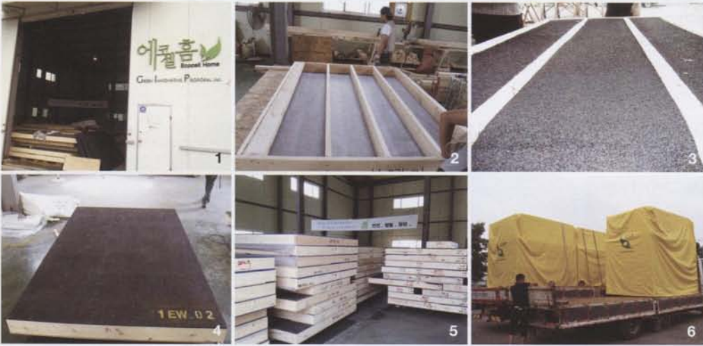
1 에코셀 공장 전경. 2 골조부 제작. 3 왕겨솜 충전. 4 외벽면 숫바름. 5 조립 순서대로 적재. 6 운송. • 에코셀은 정확한 컴퓨터 시스템을 적용해 설계에 따른 정확한 치수와 물량 산출이 가능하다. 그래서 에코셀 공법뿐만 아니라 일반적으로 공장화건축 시스템은 시공 중에 설계 변경이 불가능한 경우가 많다.
